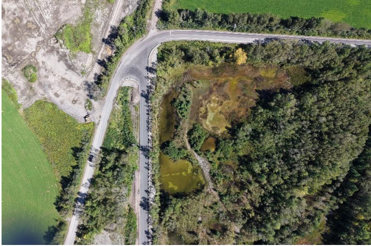
Asphaltage de la route d'accès
