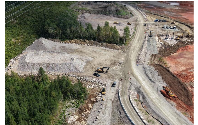
Digue 7 (en cours)
