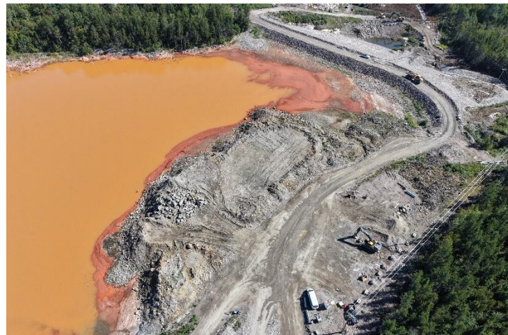
Digue 5 (en cours)
