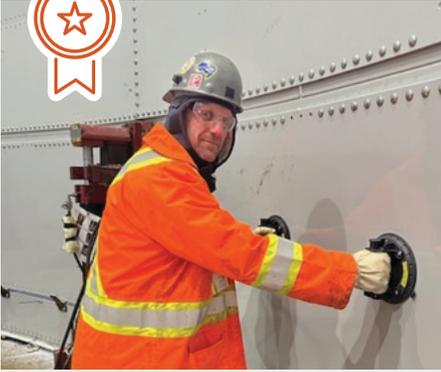
L'équipe AlcoTD utilise des ventouses pour placer les plaques du silo. Ces ventouses permettent un meilleur contrôle du champ magnétique et évitent les risques de coincement des doigts. Sur la photo, nous pouvons voir Danny Bélanger, chaudronnier.
