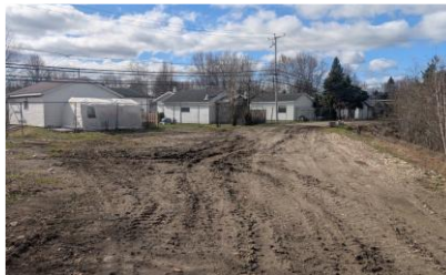
Rue Fillion - travaux pour retirer l'ancienne conduite à venir
