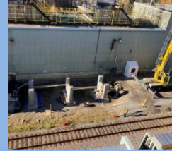
Travaux civils et électriques
