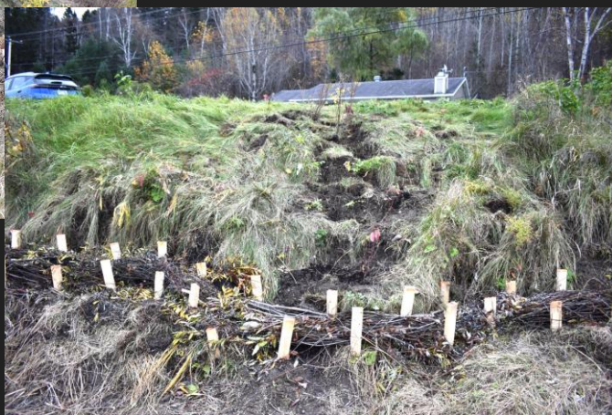
Certains aménagements réalisés : Boudins pré-végétalisés et fascines de saules
